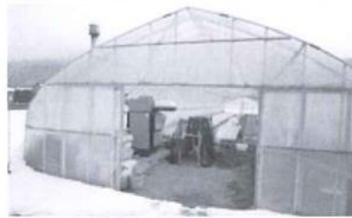
▲ペレットボイラーを設置
